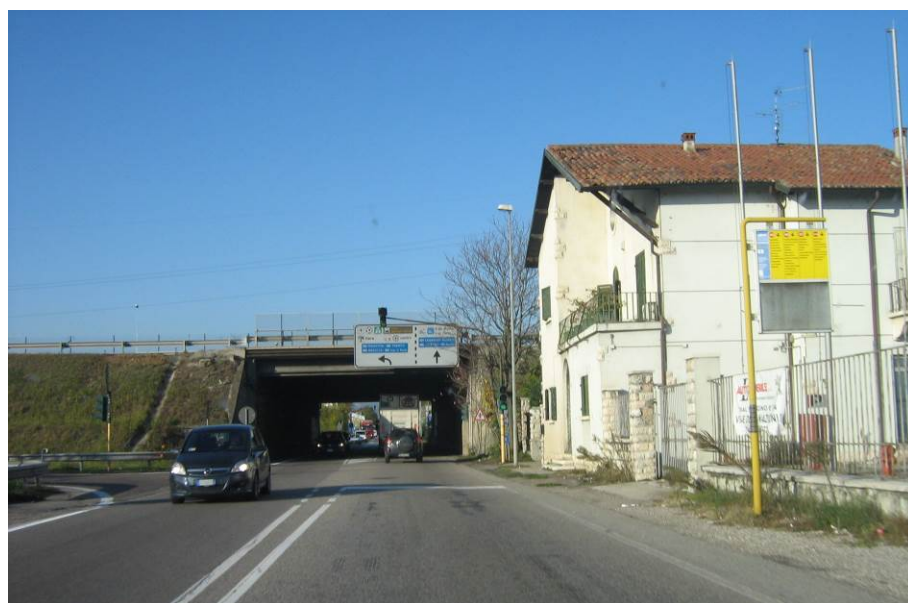
Figura 8 – Intersezione 4 – SS 12/rampa di uscita Tangenziale Sud
